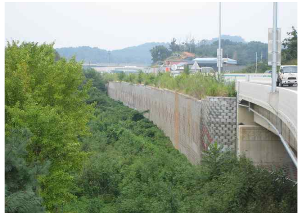
1공구 보강토옹벽(지선 STA.0+321~0.680)
