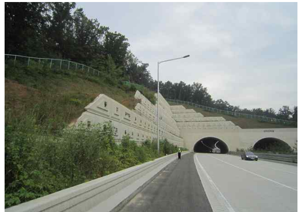
1공구 보강토옹벽(본선 STA.6+933~7+040)
