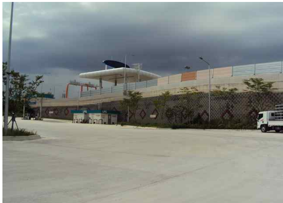
1공구 보강토옹벽(본선 STA.4+993~5+110)
