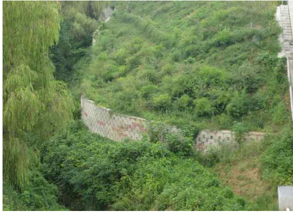
1공구 보강토옹벽(본선 STA.0+283~0+400)
