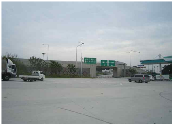
1공구 보강토옹벽(본선 휴게소통과교량)
