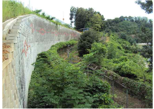
1공구 보강토옹벽(본선 STA.1+914~2+020)
